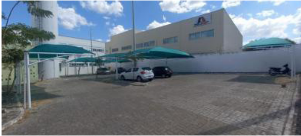
FOTO 37 – Cobertura Estacionamento Sobral
