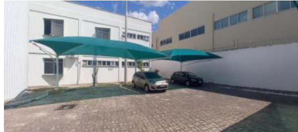
FOTO 38 – Cobertura Estacionamento Sobral
