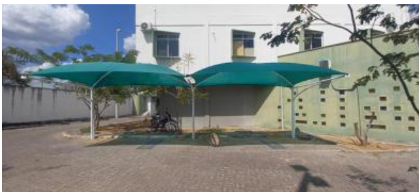
FOTO 39 – Cobertura Estacionamento Sobral
