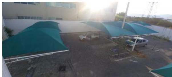
FOTO 40 – Cobertura Estacionamento Sobral
